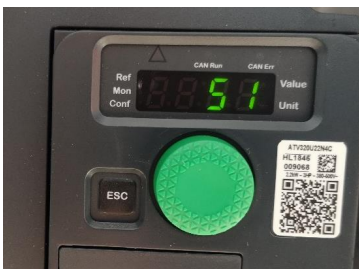
fig. 44. Anzeige der Betriebszeit bei einem Gerät mit dreiphasiger Stromversorgung 400 V + Neutralleiter
